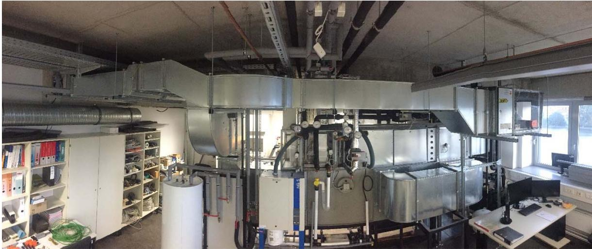
Abbildung B-10: Labor G 318 – Vollklimaanlage, Darstellung der montierten Abluftanlage (oben), der Rauchklappen (links) und Anschluss der Zuluft an die Bestandsanlage
